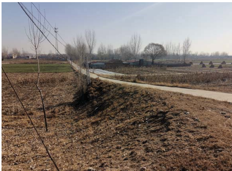
主体工程区——上堤坡道
