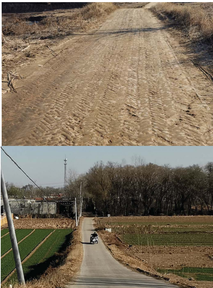
施工道路现状
