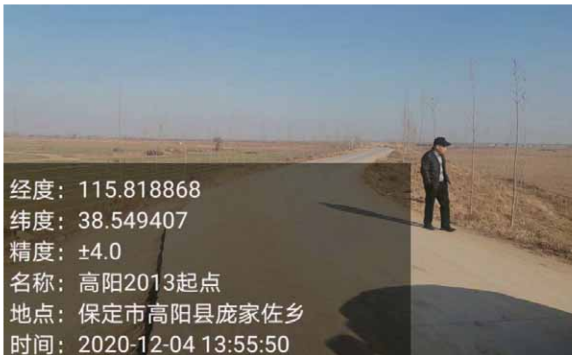
照片1 堤顶道路及两侧植被现状
