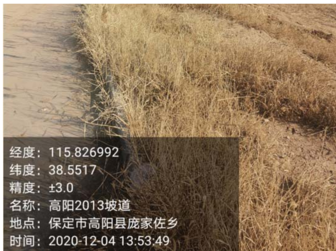
照片3 上堤坡道及边坡植草现状
