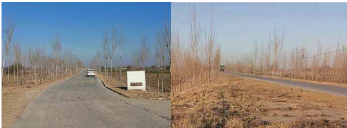
照片1 堤顶道路及两侧植被现状
