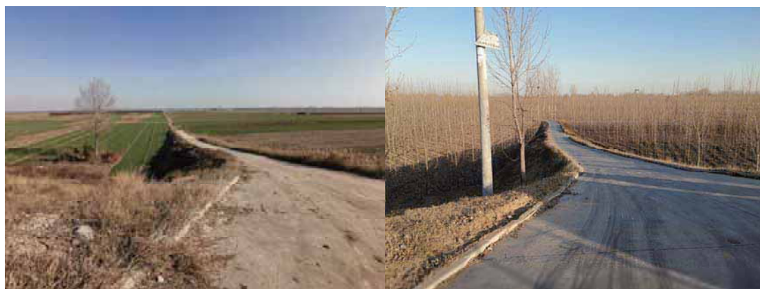
照片2 上堤坡道及边坡植草现状
